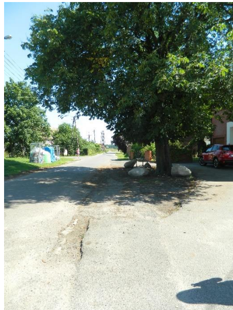
Rysunek 33. Droga prowadząca do świetlicy wiejskiej w Grodźcu Małym (źródło: CDE Sp. z o.o.)
